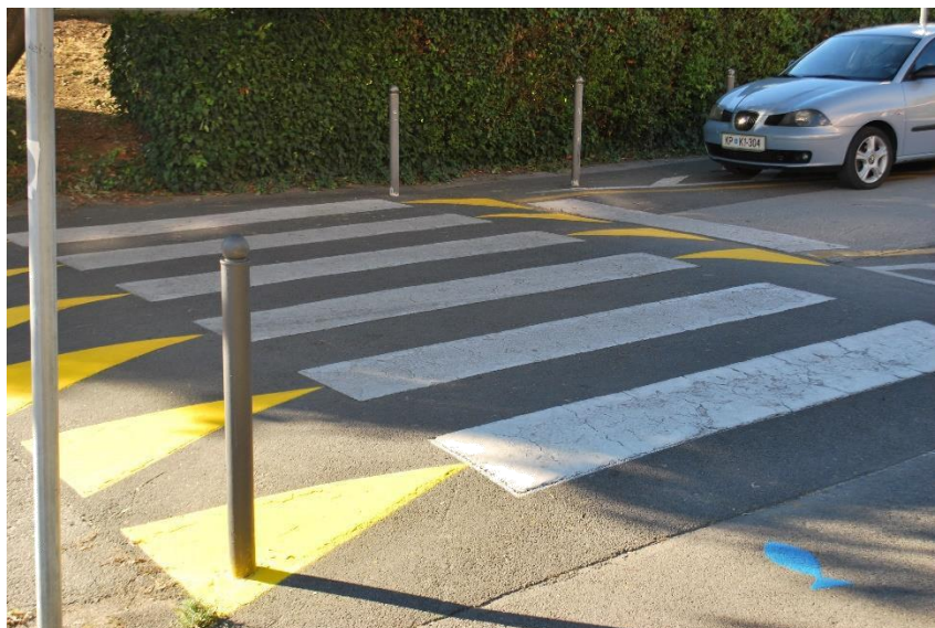
PT 6 (prehod za pešce ulica Oktobrske revolucije – pri vrtcu)
